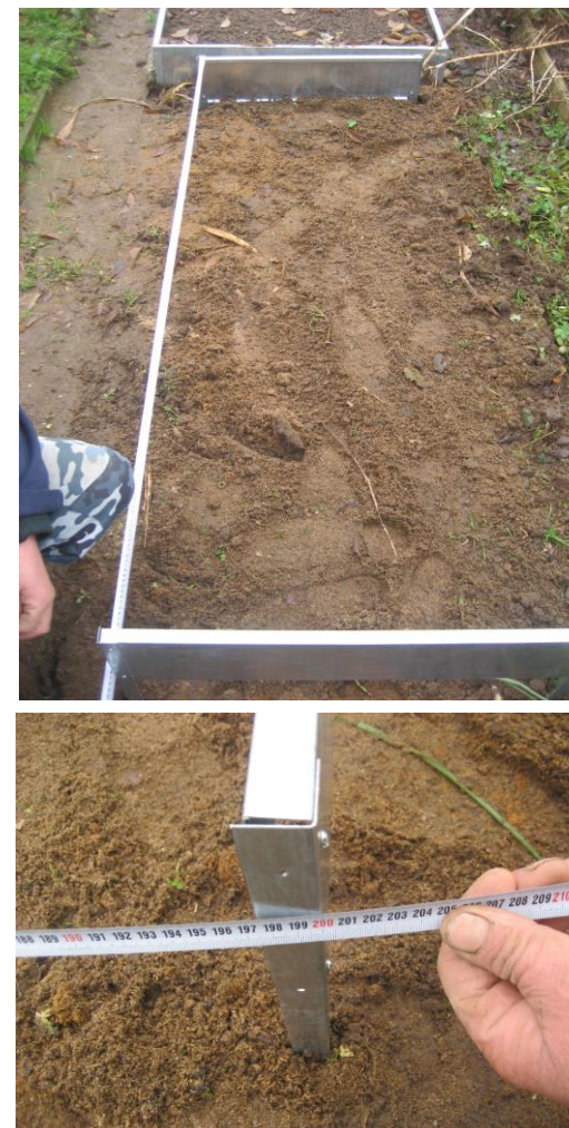
Фото 2. Установка боковых стенок
